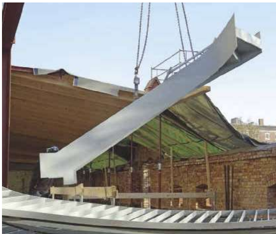
Die vorgefertigten Teile der Treppe werden mit dem Kran durch die noch offene Decke eingebracht
