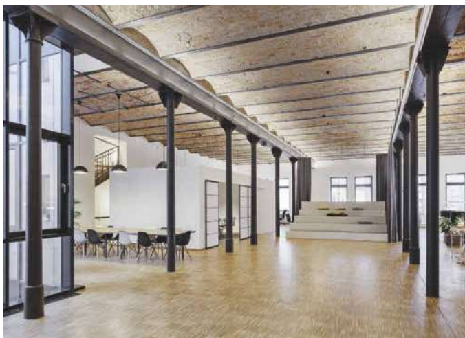
Die historische, auf gusseisernen Stützen lastende Kappendecke ist auch nach der Sanierung das raumprägende Element
