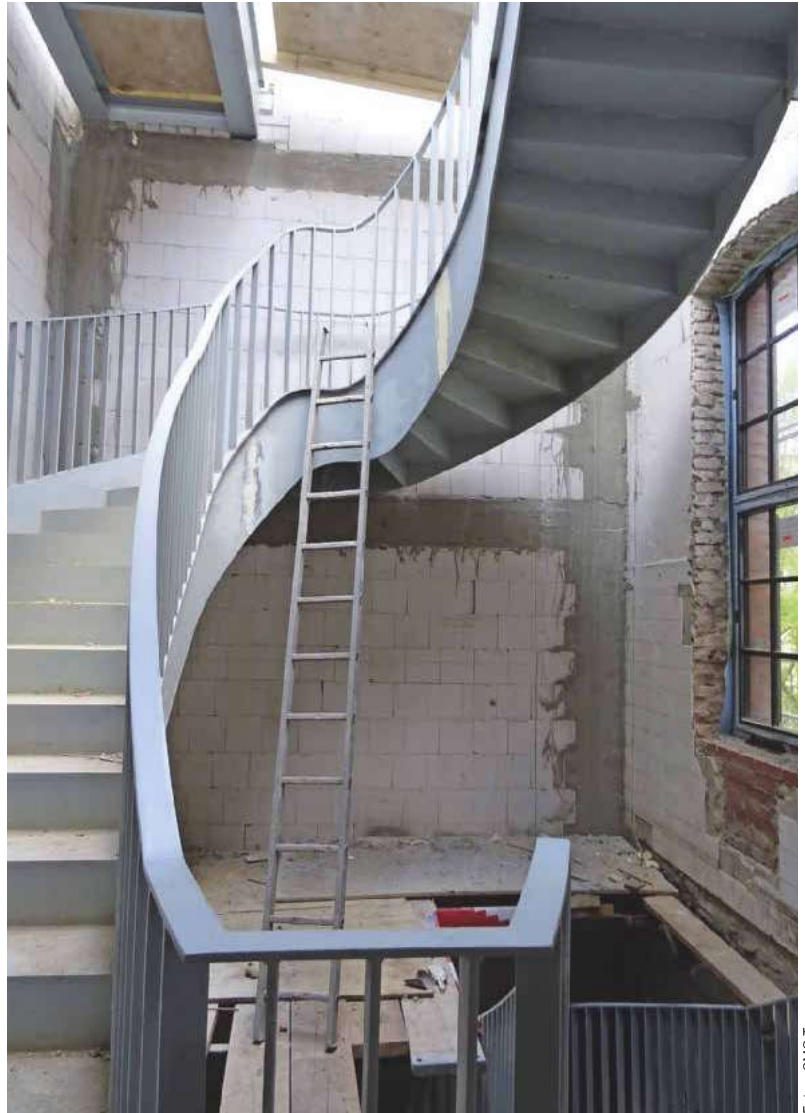
Die gebogene Flachstahlwangentreppe mit Wangen aus 15 mm Stahlblech wurde vor Ort aus sechs Segmenten von oben beginnend verschweißt
